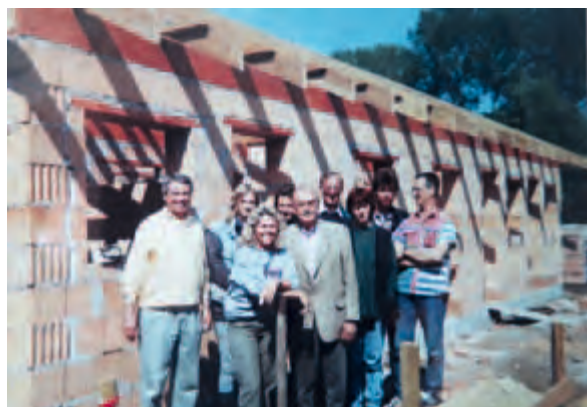
Richtfest vom Quarantäne-Neubau 2001
